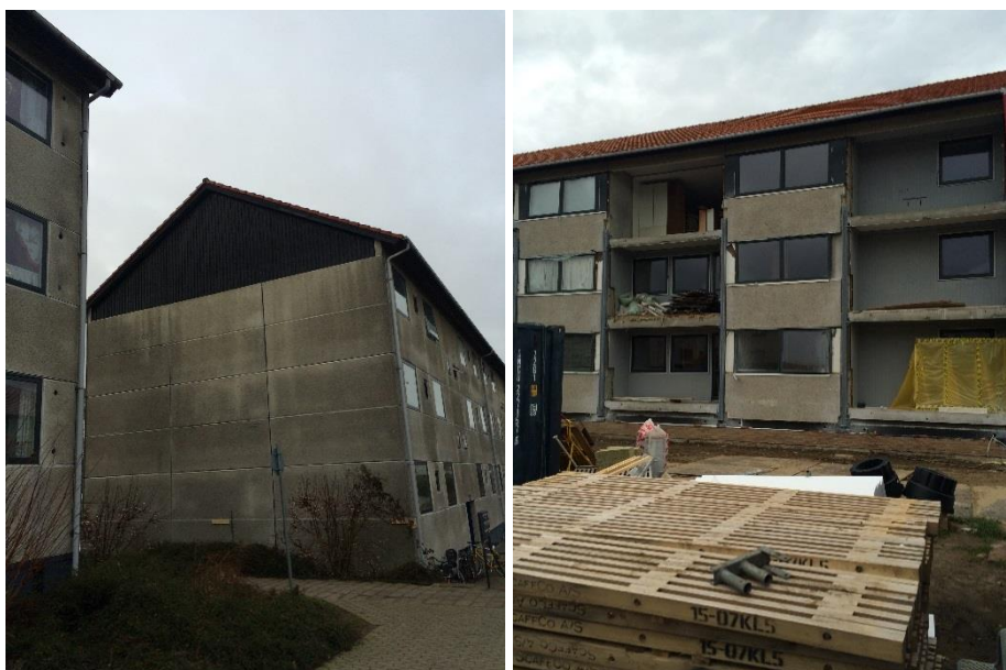
Figur E.1.3 - Foto af gavl og facaderne
