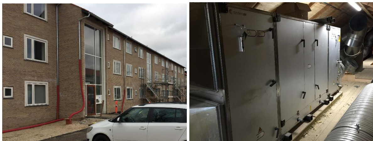
Figur E.2.2 - TV ses den nye facade med de 2 typer af nye indgangspartier. TH ses et af de nye balancerede ventilationsanlæg på loftet
