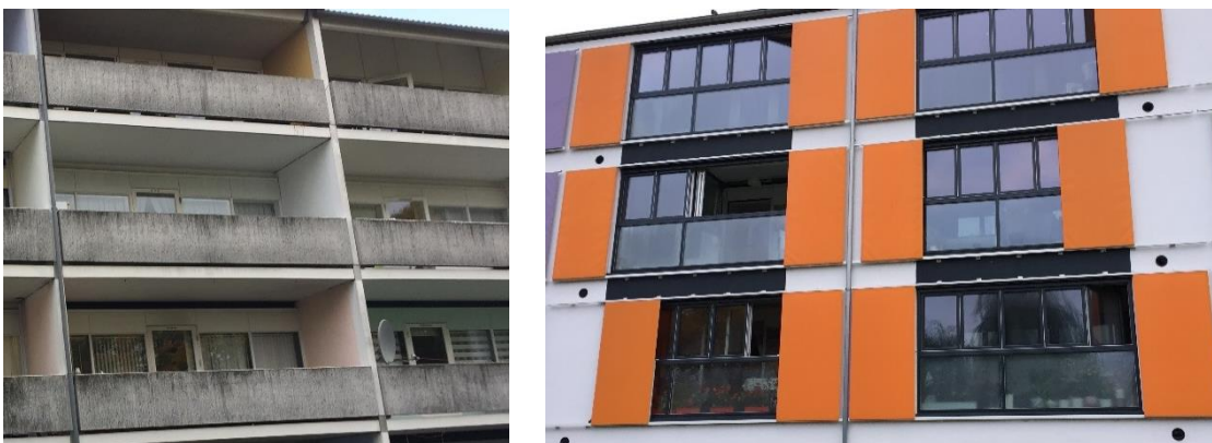
Figur D.2.1 - Eksisterende altaner (tv.) og altaner efter renovering (th.)
