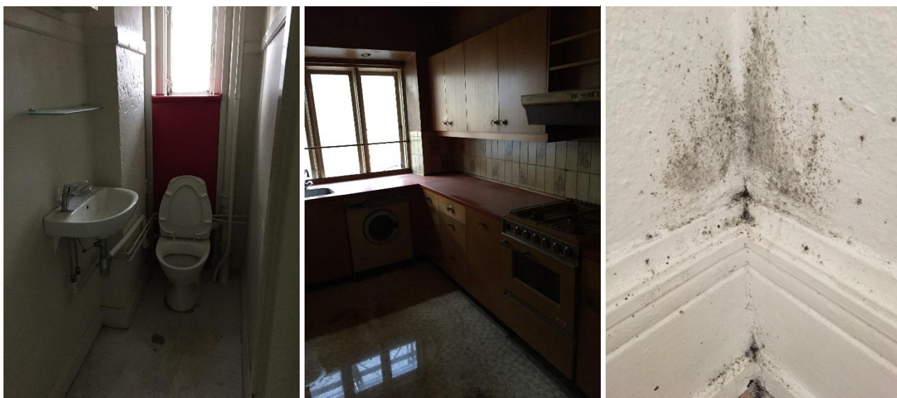
Figur F.2.3 - Foto indvendigt i lejligheder før renovering
