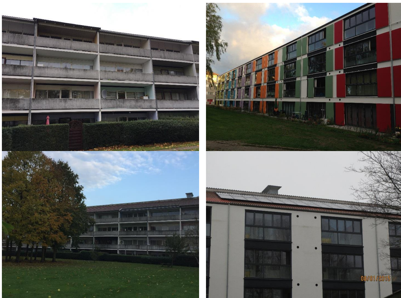
Figur D.2.4 - Billeder fra ejendommens sydlige facade med altaner. Tv: Eksisterende ejendom, th: Renoveret ejendom
