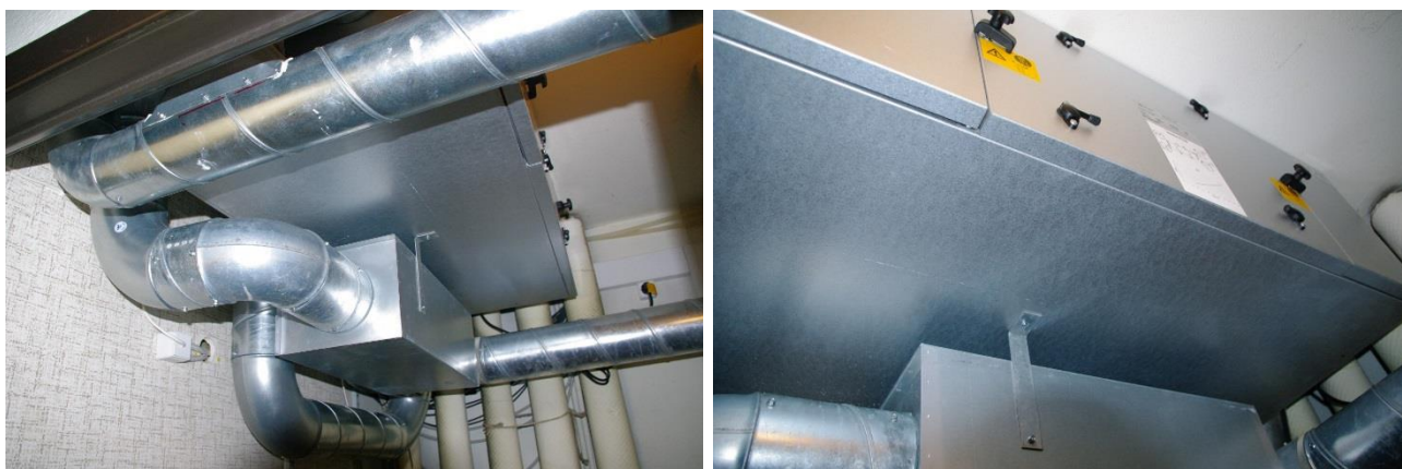
Figur D.4.3 - Nyt decentralt balanceret mekanisk ventilationsanlæg med varmegenvinding placeret i skab. TV: Ventilationsaggregat inkl. kanalføring og lyddæmper, TH: Zoom på ventilationsaggregat
