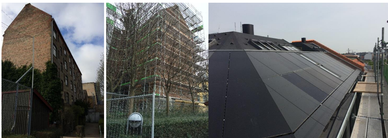
Figur F.2.4 - TV facade og gavl før renovering, MF og TH facade, gavl og tagetage under renovering
