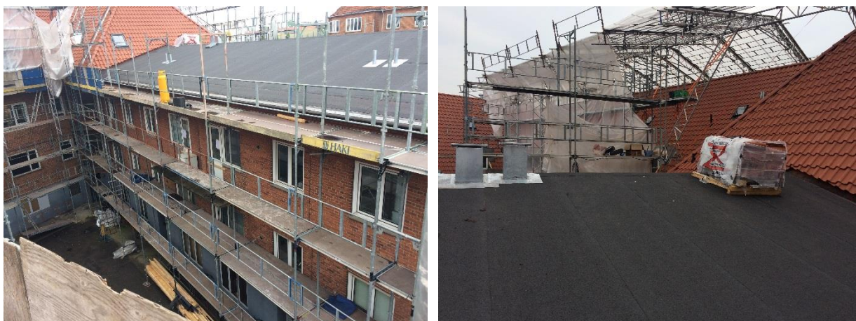
Figur H.2.1 - foto af facade og tag under renovering
