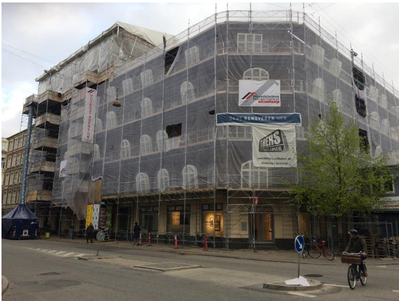
Figur I.2.3 - Foto af ejendommen med stillads
