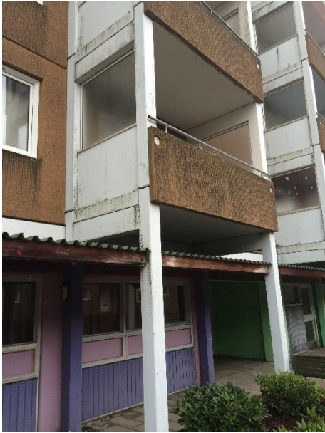
Figur G.2.4 - Foto af altan og kælderetage før renovering
