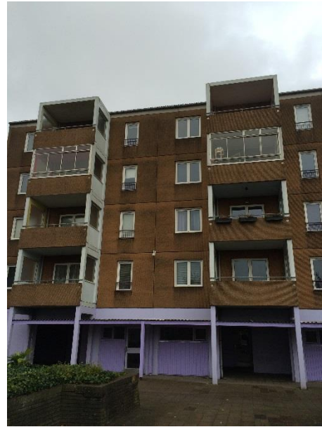
Figur G.2.5 - Foto af altaner før renovering
