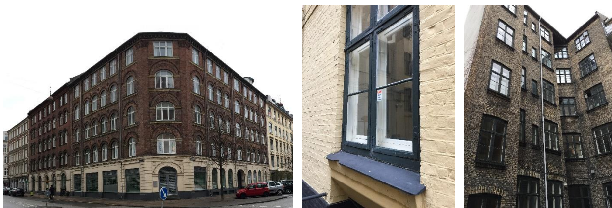
Figur I.1.1 - Ejendommen før renovering fra gaden og fra gården plus et eksempel på den originale vinduesløsning
