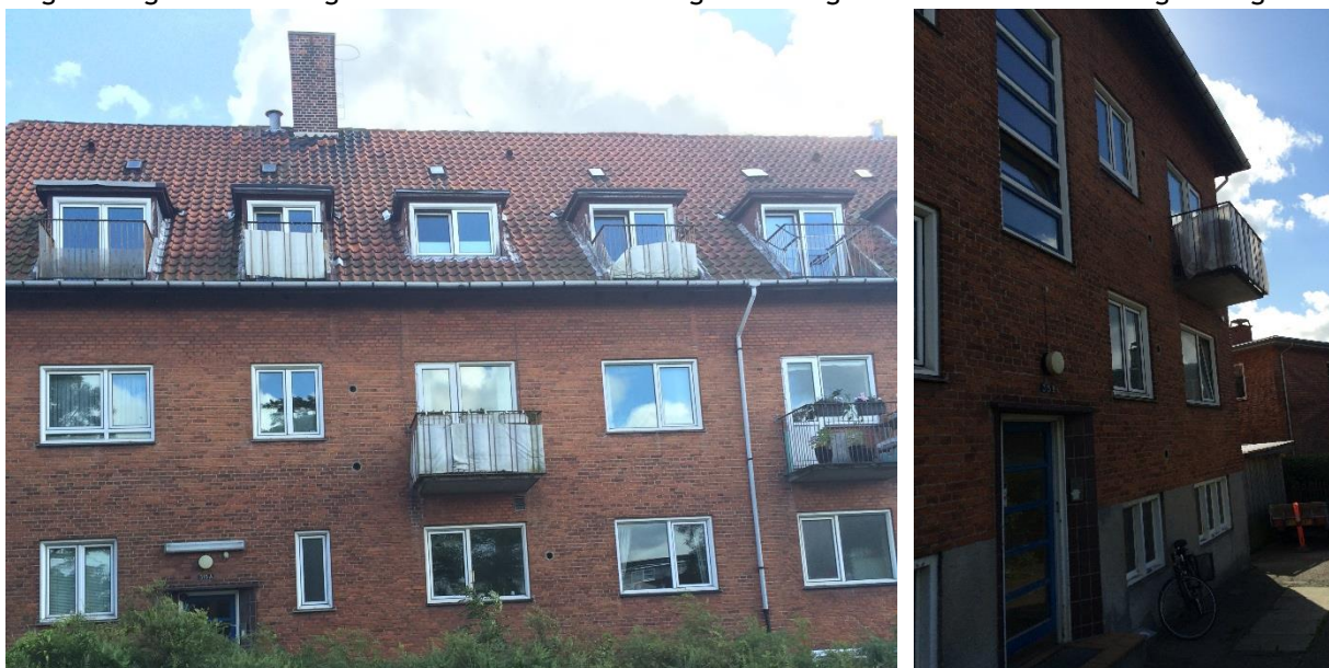
Figur H.1.5 - foto af tag og facade inden renovering
