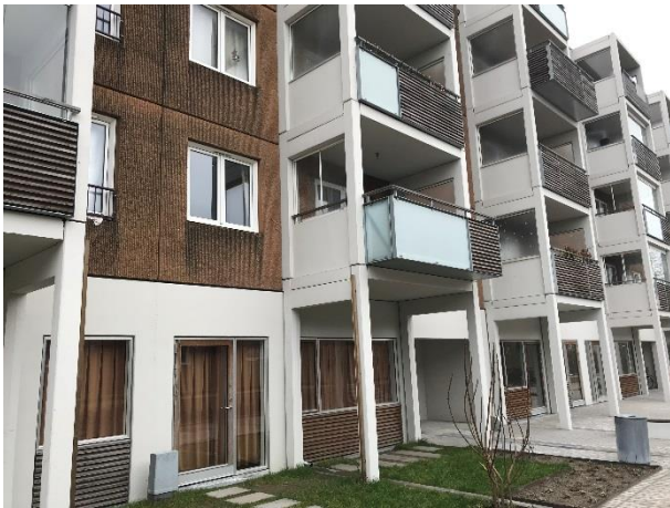
Figur G.2.6 - Foto af altan og parterre kælder efter renovering
