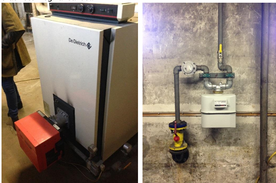
Figur H.1.6 - Den gamle gaskedel og måleren
