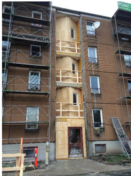
Figur G.2.2 - Foto af indgangsparti under renovering
